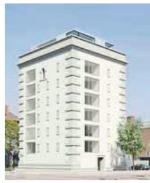
Schon als Baustelle ein Hingucker: In die zwei Meter dicken Wände des ehemaligen Bunkers in der Ungererstraße wurden große Fenster gebrochen.
