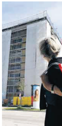
Schon als Baustelle ein Hingucker: In die zwei Meter dicken Wände des ehemaligen Bunkers in der Ungererstraße wurden große Fenster gebrochen.
