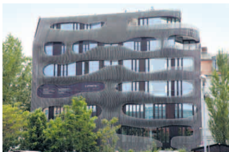
Markant Die Außenfassade besteht aus vertikal angeordneten Lamellen, die einen dreidimensionalen Effekt erzeugen
